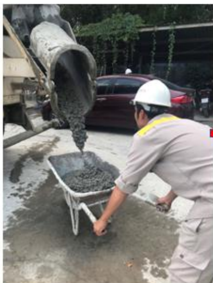
Lấy bê tông
