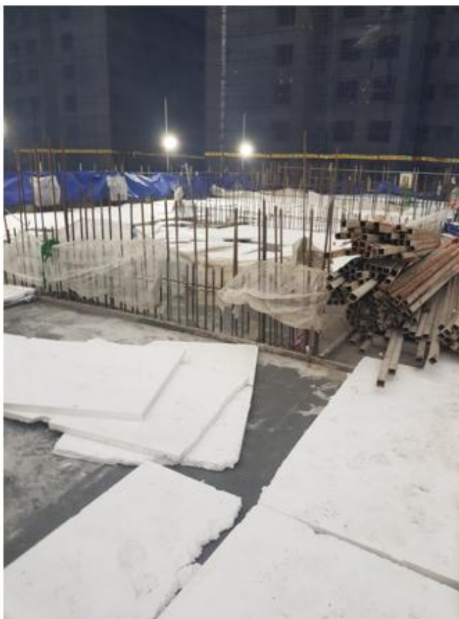
Bảo ôn bê tông
