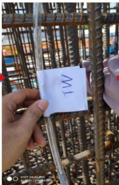
Lắp sensor và đánh dấu vị trí
