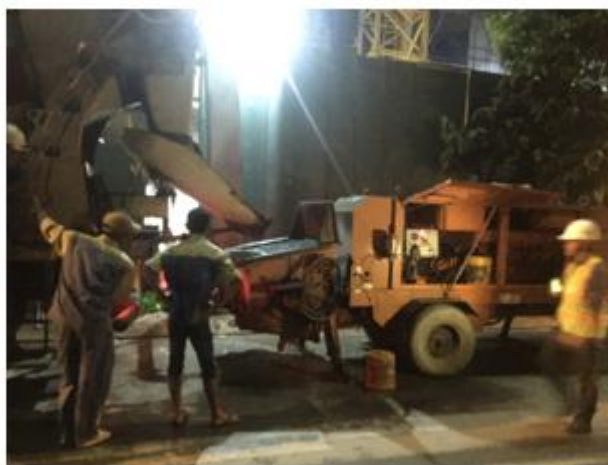
Công tác bơm bê tông
