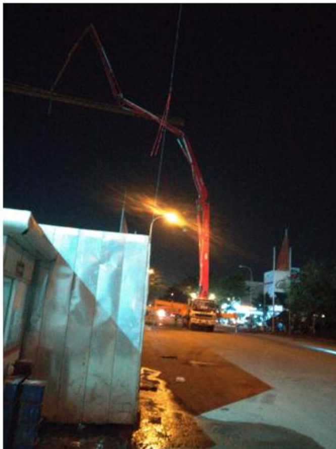
Công tác bơm bê tông
