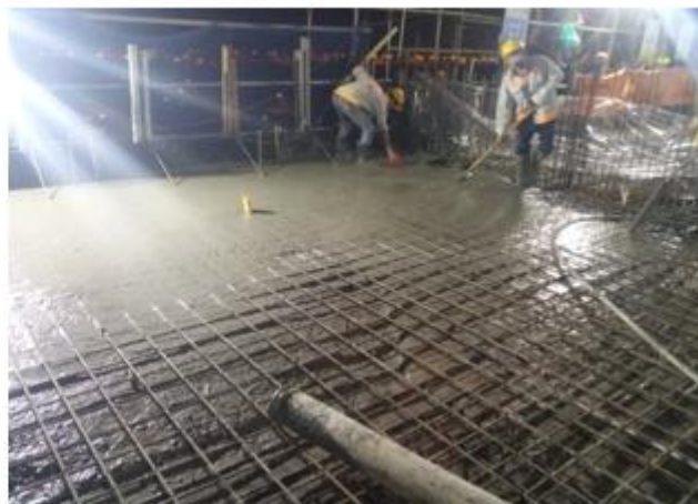
Bơm bê tông vào cấu kiện
