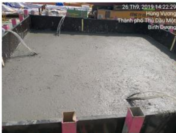
Làm mặt bê tông
