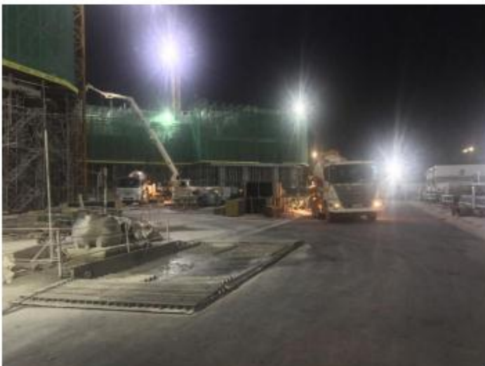
Bơm bê tông vào cấu kiện
