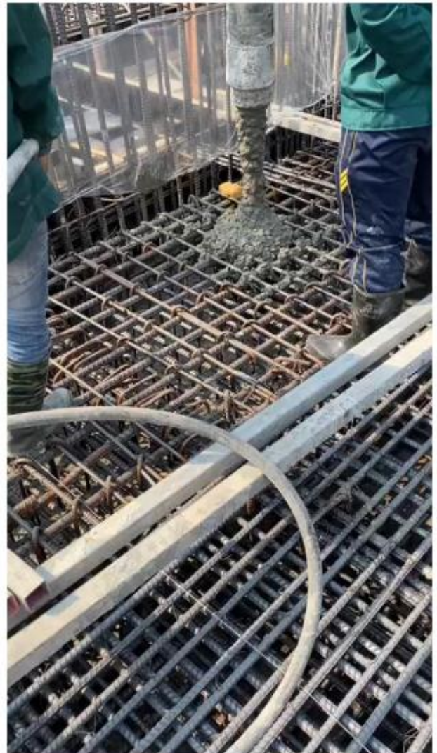
Bơm bê tông vào cấu kiện
